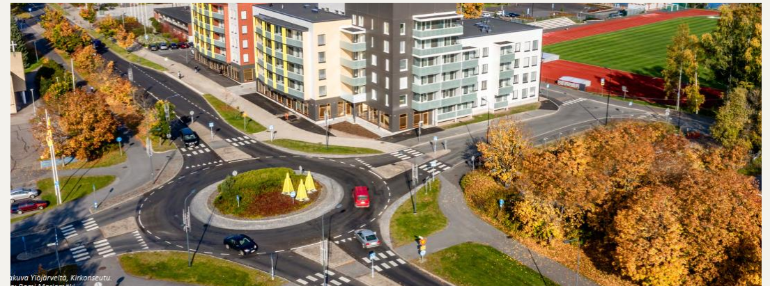
Raitiotie muuttaa katuympäristöä merkittävästi. Kuruntielle raitiotie muuttaa mm. kiertoliittymät valo-ohjatuiksi tasoliittymiksi. Raitiotie on suunniteltu kulkevaksi kadun keskellä omilla kaistoillaan.
